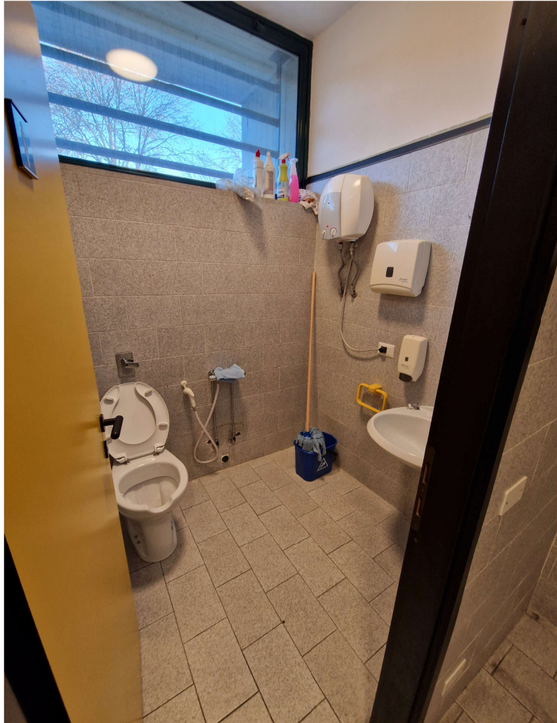
LOCALE WC 2 (adeguamento servizi igienici)
