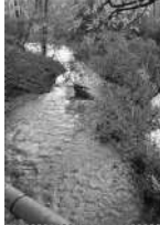
Alberatura caduta in alveo in sponda su con conseguente ostruzione in alveo (foto dalla passerella pedonale)
