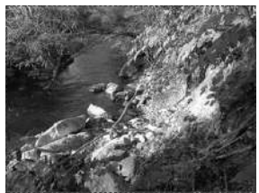
Erosione in alveo in sponda dx a valle della sponda dx
