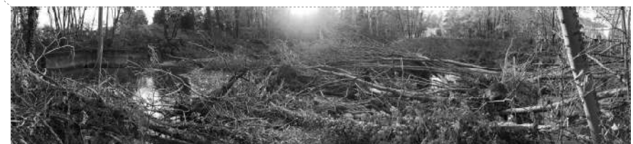
Importante erosione in sponda su con caduta di tronchi (foto) e alberature in alveo
