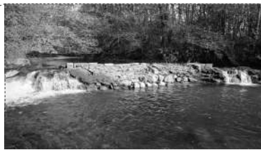
Segna di deviazione (non più attiva) in medesimo stato di manutenzione
