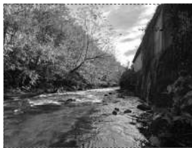
Alberatura in alveo verso l'alveo potenzialmente pericolosa in sponda dx
