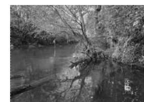
Erosione sponda in sponda su, con caduta di alberi e conseguente ostruzione in alveo
