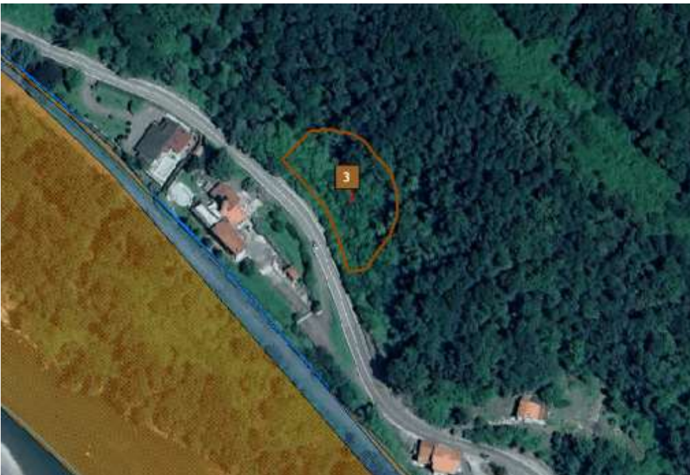
3 - Movimento Franoso sulla strada Provinciale 75.
