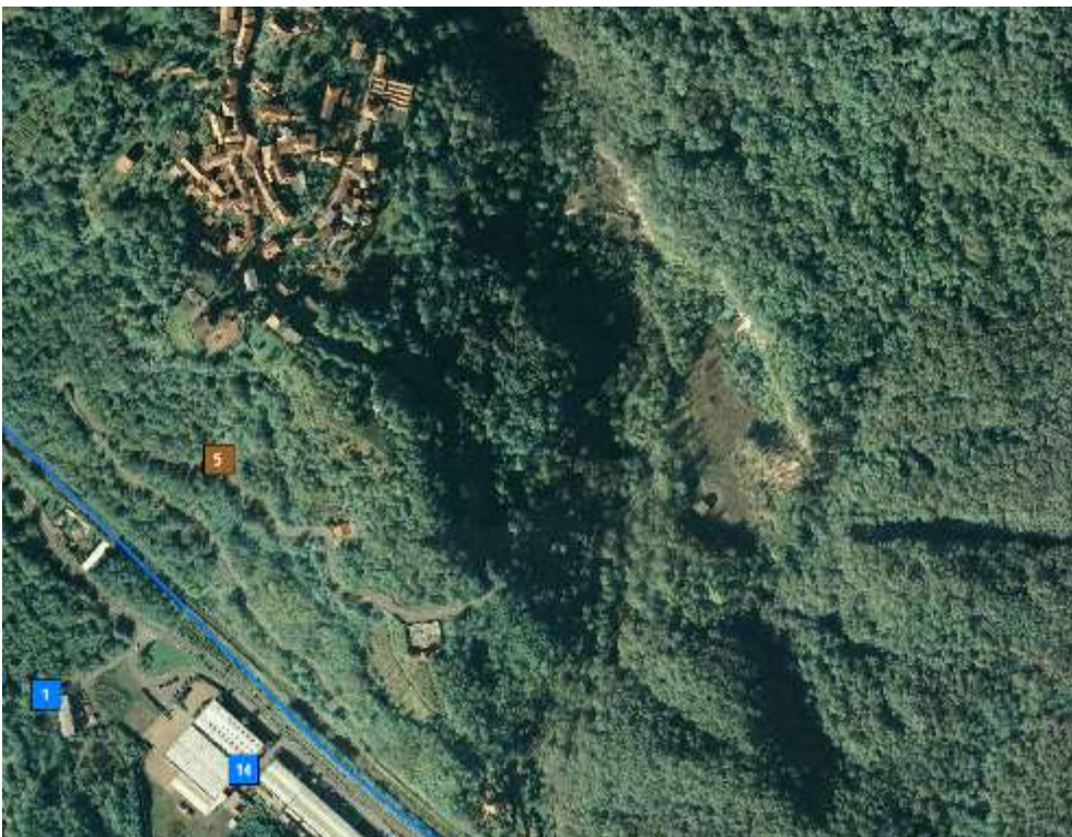
5 - Possibili frane sulla Strada per Ara.
