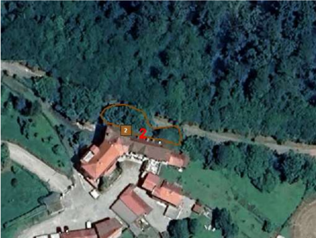
2 - Movimento franoso in località Via le Cave.
